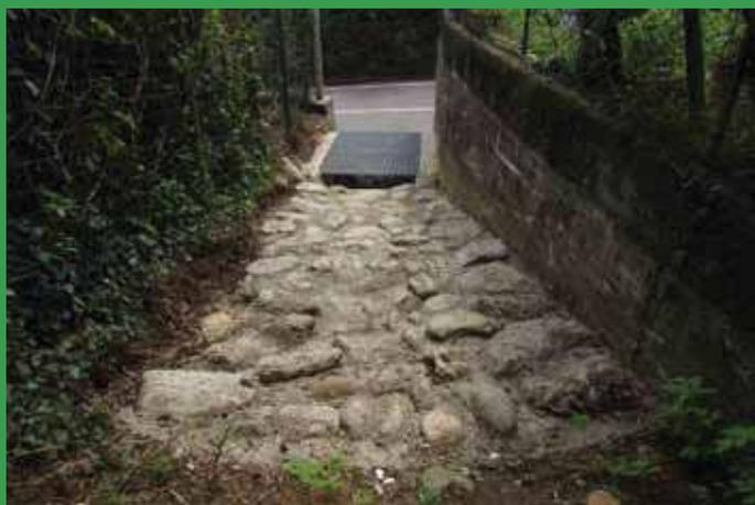
“PP” Rio Faustino, 5.800 €: pulizia camera posta all’inizio del tombotto e posizionamento pozzetto d’ispezione; ricostruzione tratto di alveo e pareti, con pietre e calcestruzzo; formazione di una nuova briglia selettiva e di contenimento con gaveta centrale.
