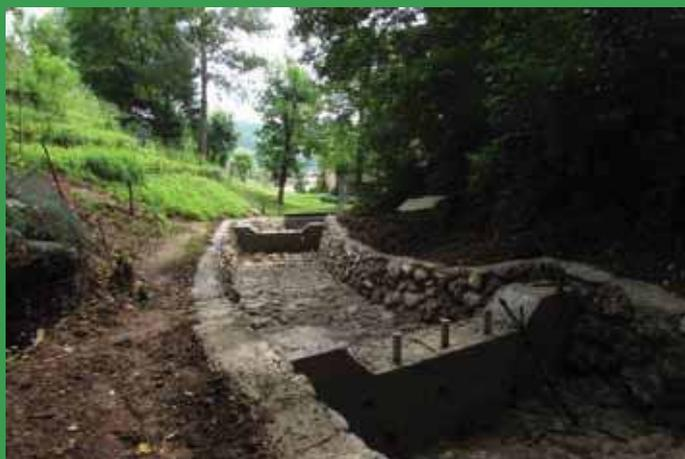
**“DD1” Valle Valbona, 4.200€:** pulizia interna tombotto; formazione di una camera di sedimentazione supplementare; posizionamento di un grigliato calpestabile e ispezionabile sulle due camere di deposito; ricostruzione del fondo dell'alveo con pietre e calcestruzzo.
