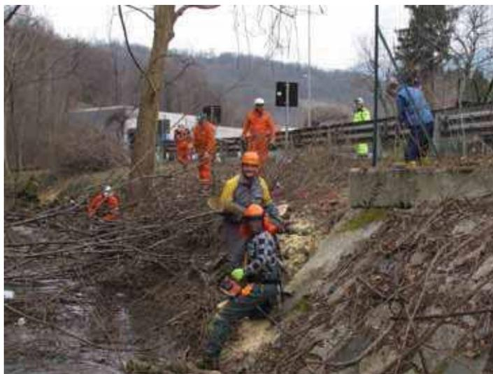
**“DD” Rio Valbona, 15.970€:** pulizia camera tombotto; sostituzione della griglia d'ingresso alla camera del tombotto con una a pettine verticale; ricostruzione di circa 15 metri di alveo e sponde, con pietre e calcestruzzo; formazione di due briglie selettive e di contenimento con gaveta centrale.
